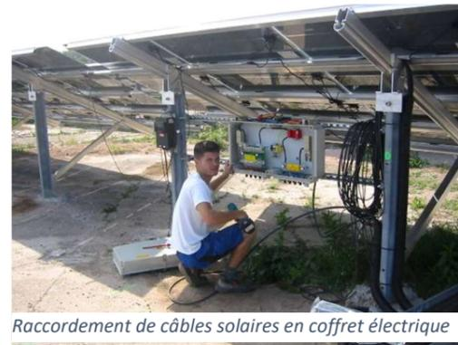
Raccordement de câbles solaires en coffret électrique
